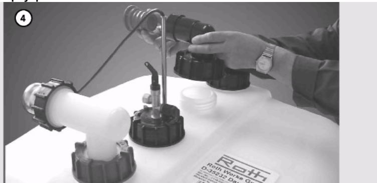
4 Угловую вентиляционную деталь с упорным уплотнением LORO-X и с плоским уплотнением Ø85/Ø68 мм x 3 мм установите на третий штуцер резервуара.
